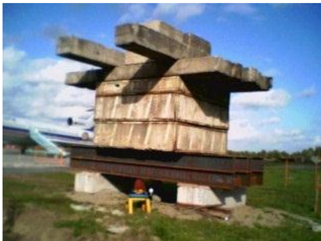
1 pav. Svorinė platforma
