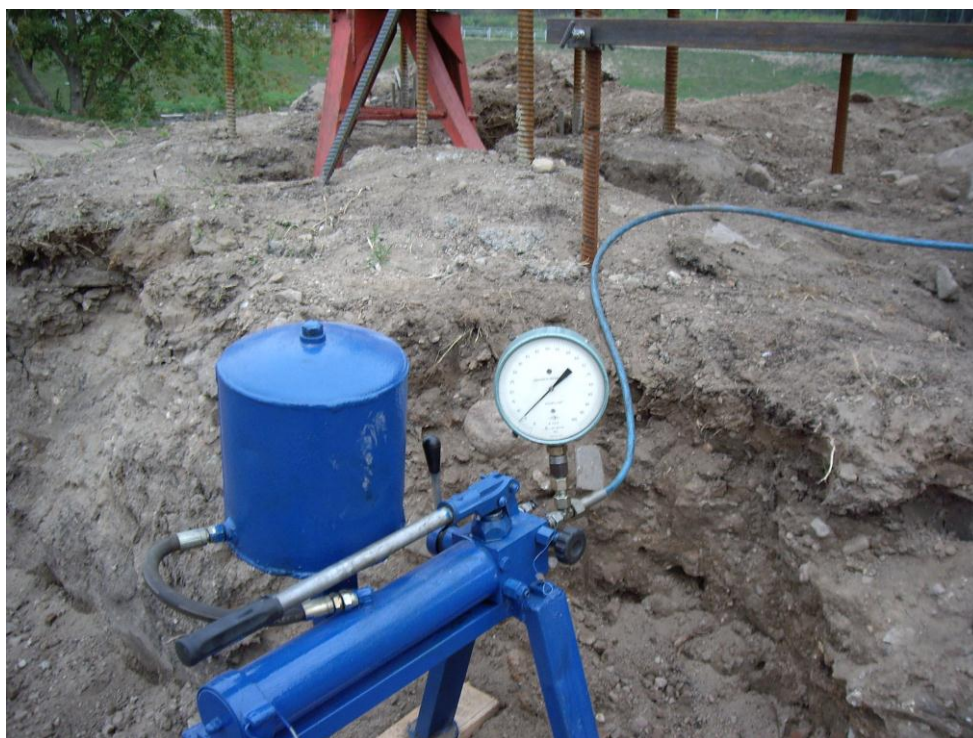
4 pav. Rankinė hidraulinė siurblinė
